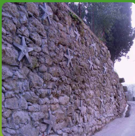
Consolidamento muri a secco
