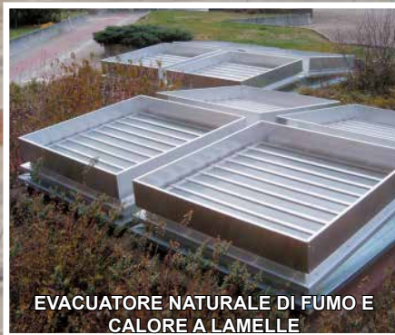
EVACUATORE NATURALE DI FUMO E CALORE - SMOKE OUT
